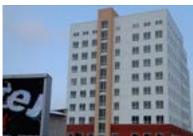
Офисный центр на ул. Крестинского, г. Екатеринбург
